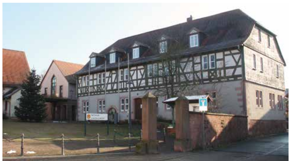
Der Amtshof nach der Renovierung, heute das Linsengerichter Rathaus
