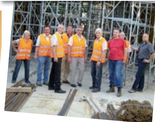
Unter Tage: Vor Ort informierte man sich über den Fortgang der Arbeiten an der Bahnunterführung
